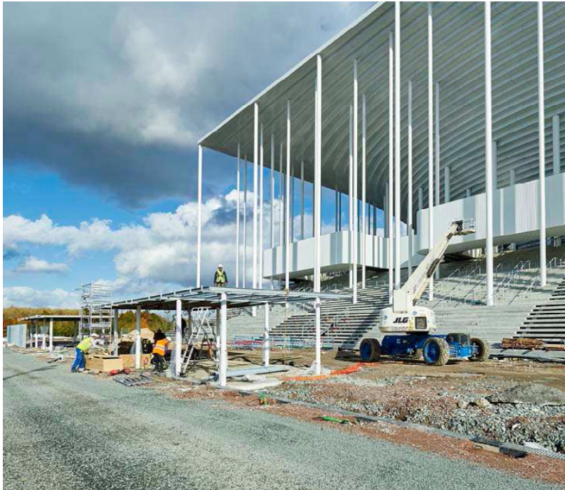
Montage des guichets d'accès du Parvis Ouest
