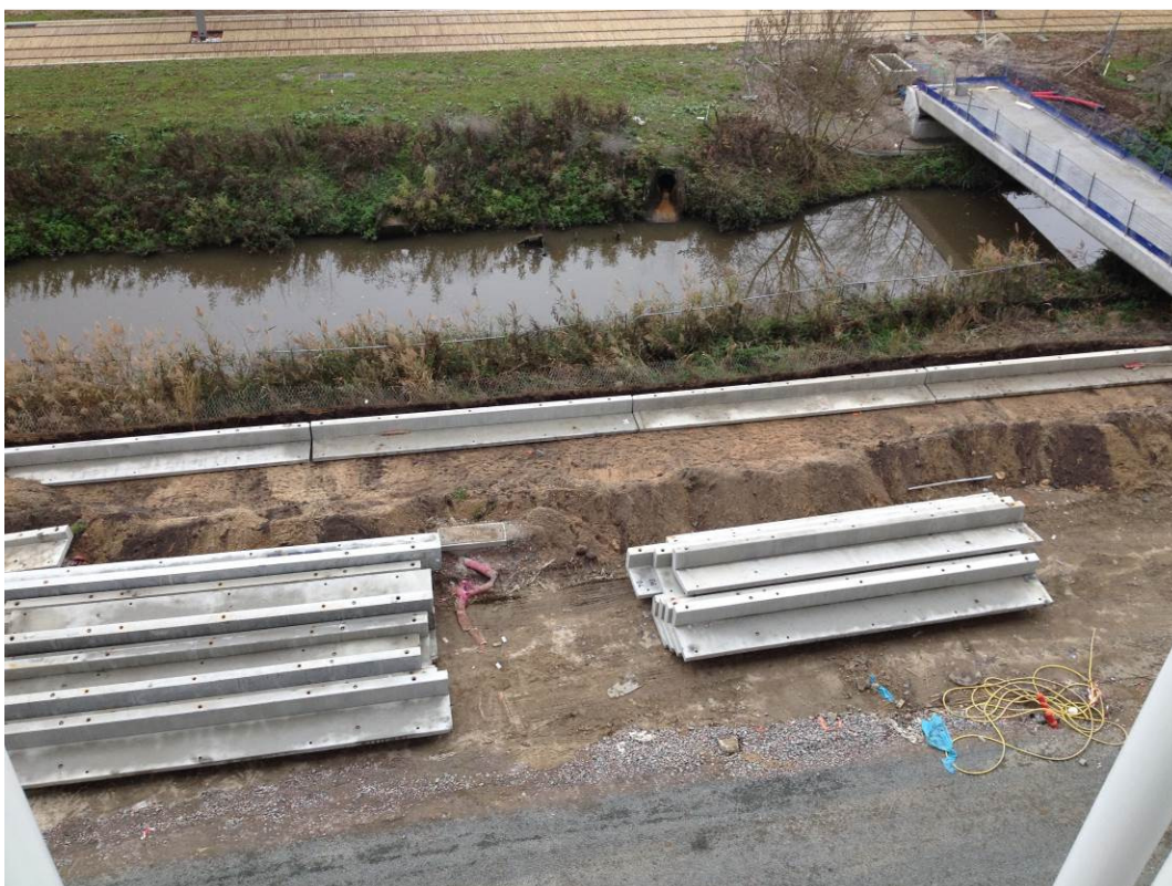
Exemple de la réutilisation des gradins en surplus comme socle des futures clôtures au Sud du projet.
