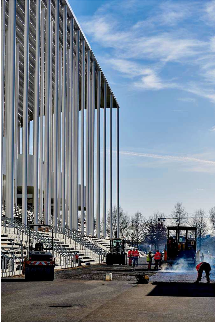
Décembre 2014 : Réalisation des enrobés parvis Ouest
