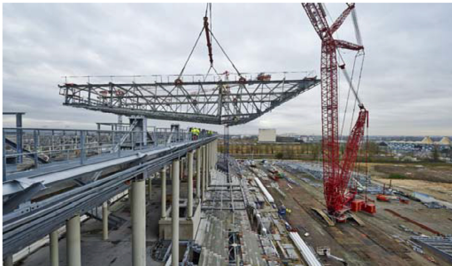
Février 2014 : Mise en place du premier élément de toiture
