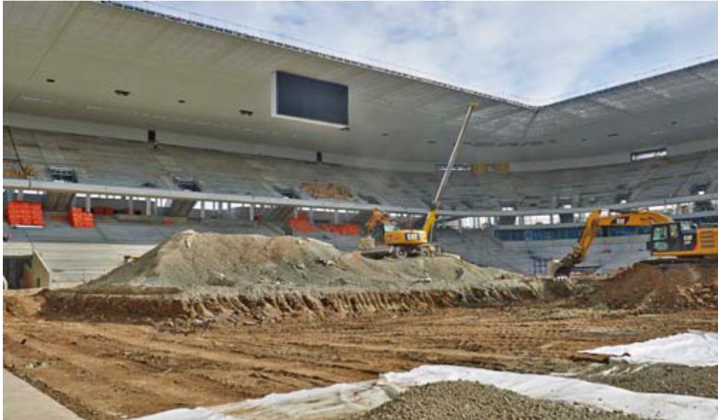
Septembre 2014 : Ecran géant posé et terrassement de la pelouse
