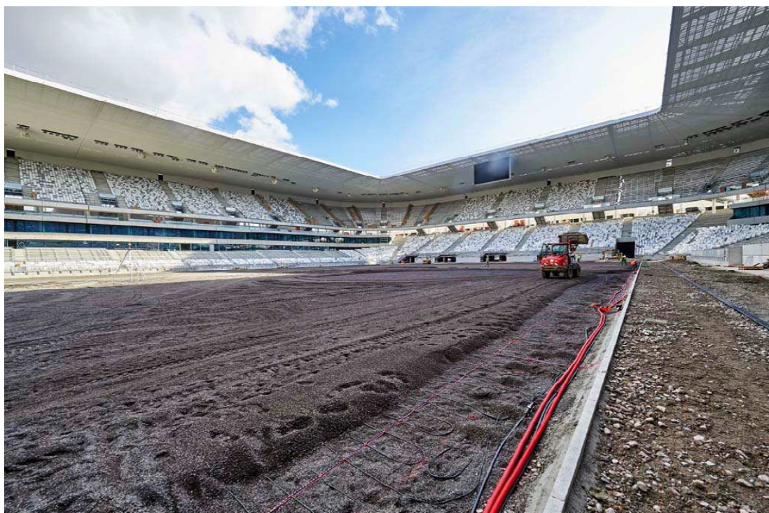
Novembre 2014 : Mise en œuvre couche drainante / chauffage pelouse
