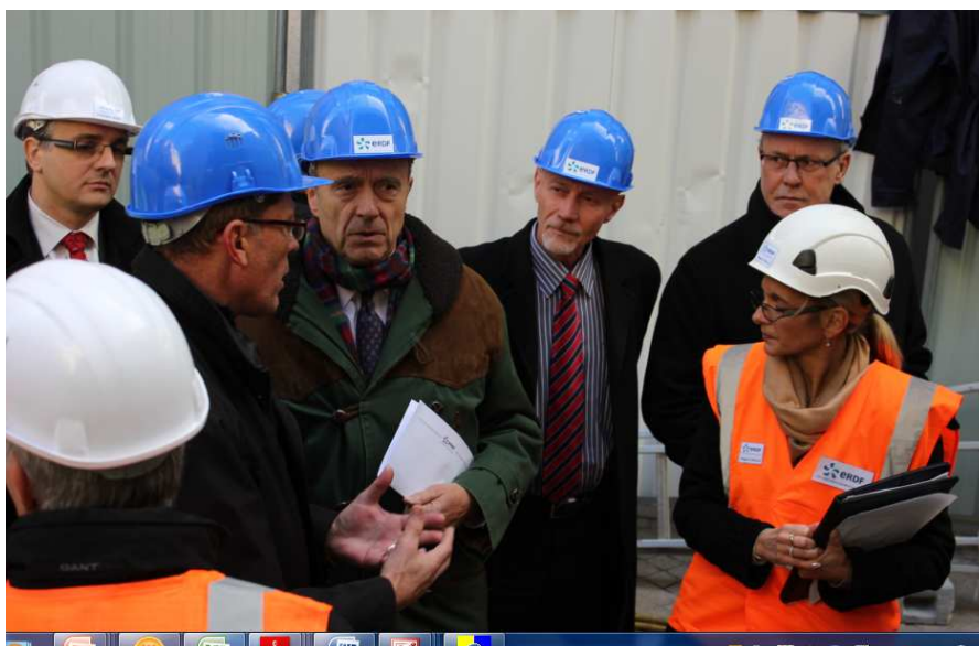
A l'occasion de l'arrivée du nouveau transformateur, le maire de Bordeaux visite le chantier en 2013.
