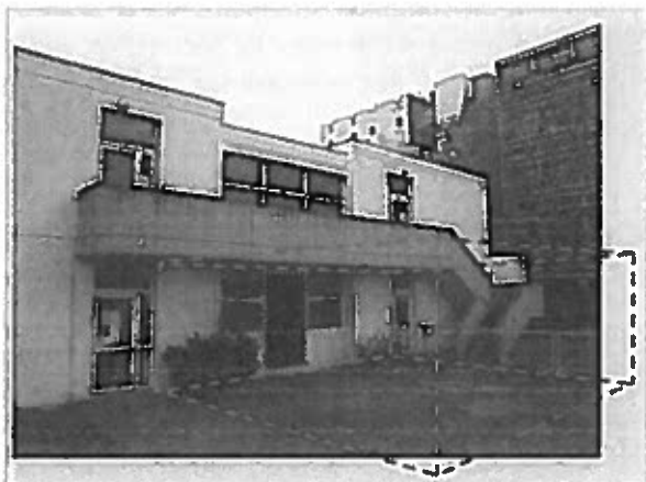
Vue sur la localisation envisagée du futur dortoir
