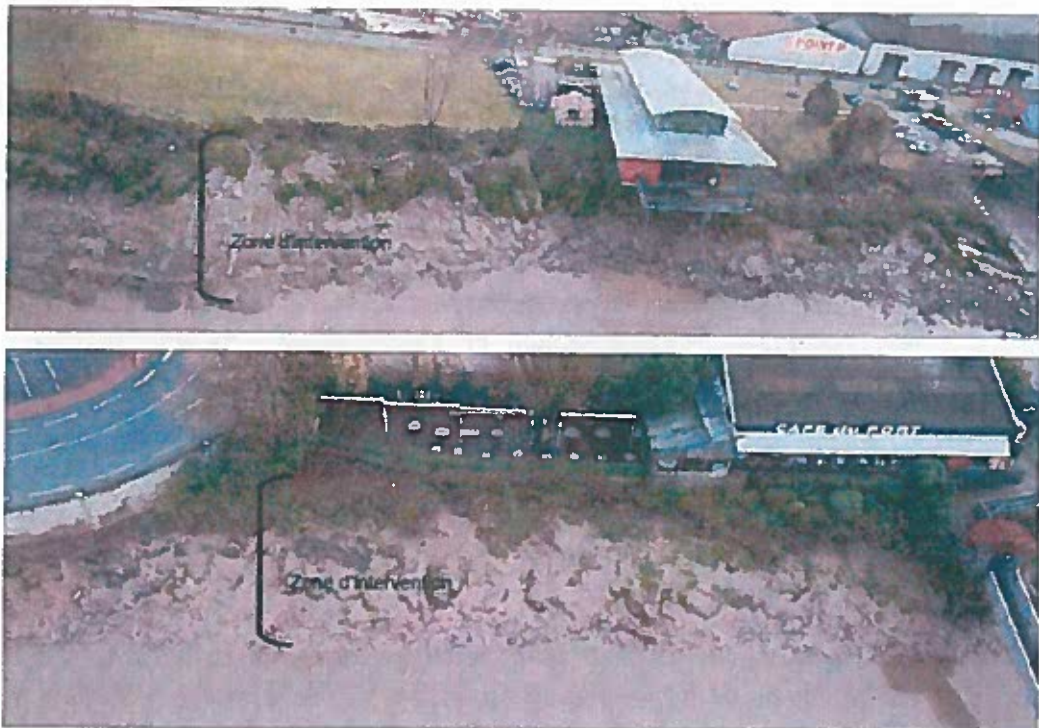
Secteurs LD VINS (en haut) et Café du port (en bas) concernés par l'expérimentation sur le confortement des berges par des techniques mixtes de restauration. Source : Etude d'impact – volet 5.
