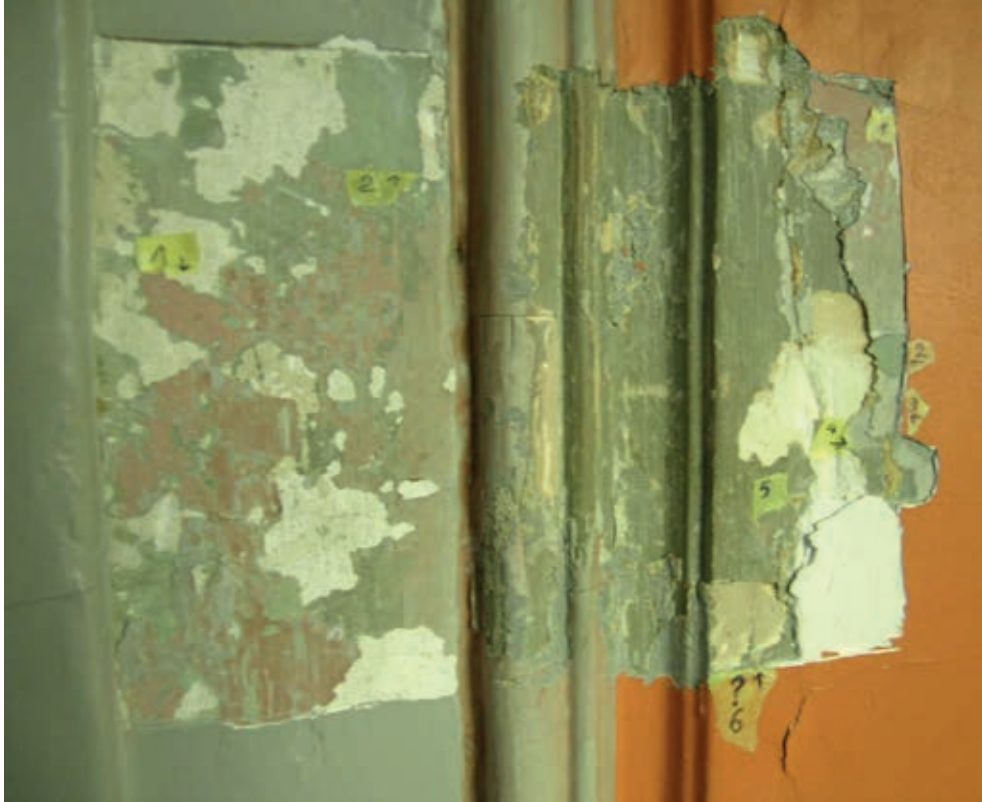
Sondages de la première salle
