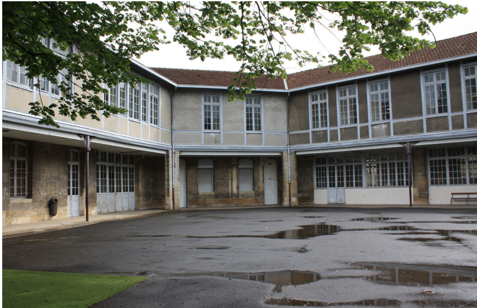
2- Façade Sud de l'Annexe Montesquieu
