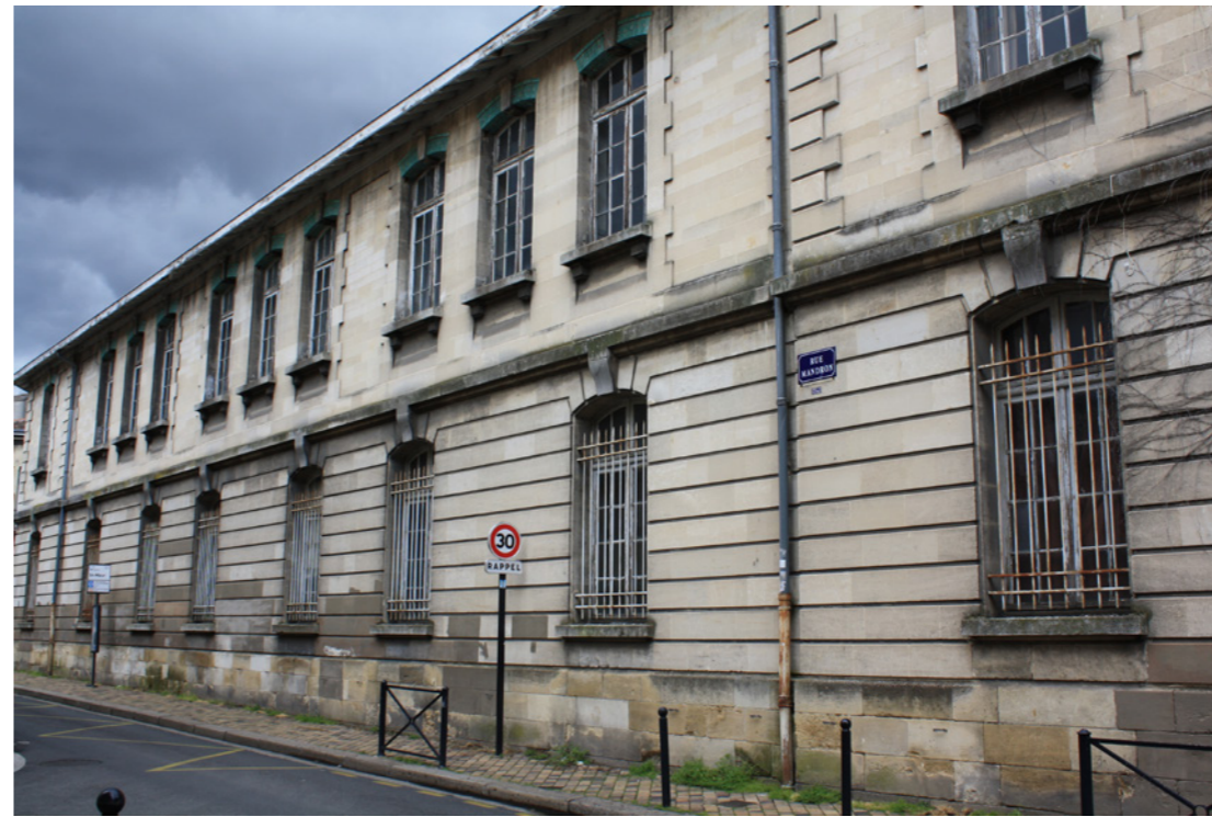
2- Façade rue Mandron
