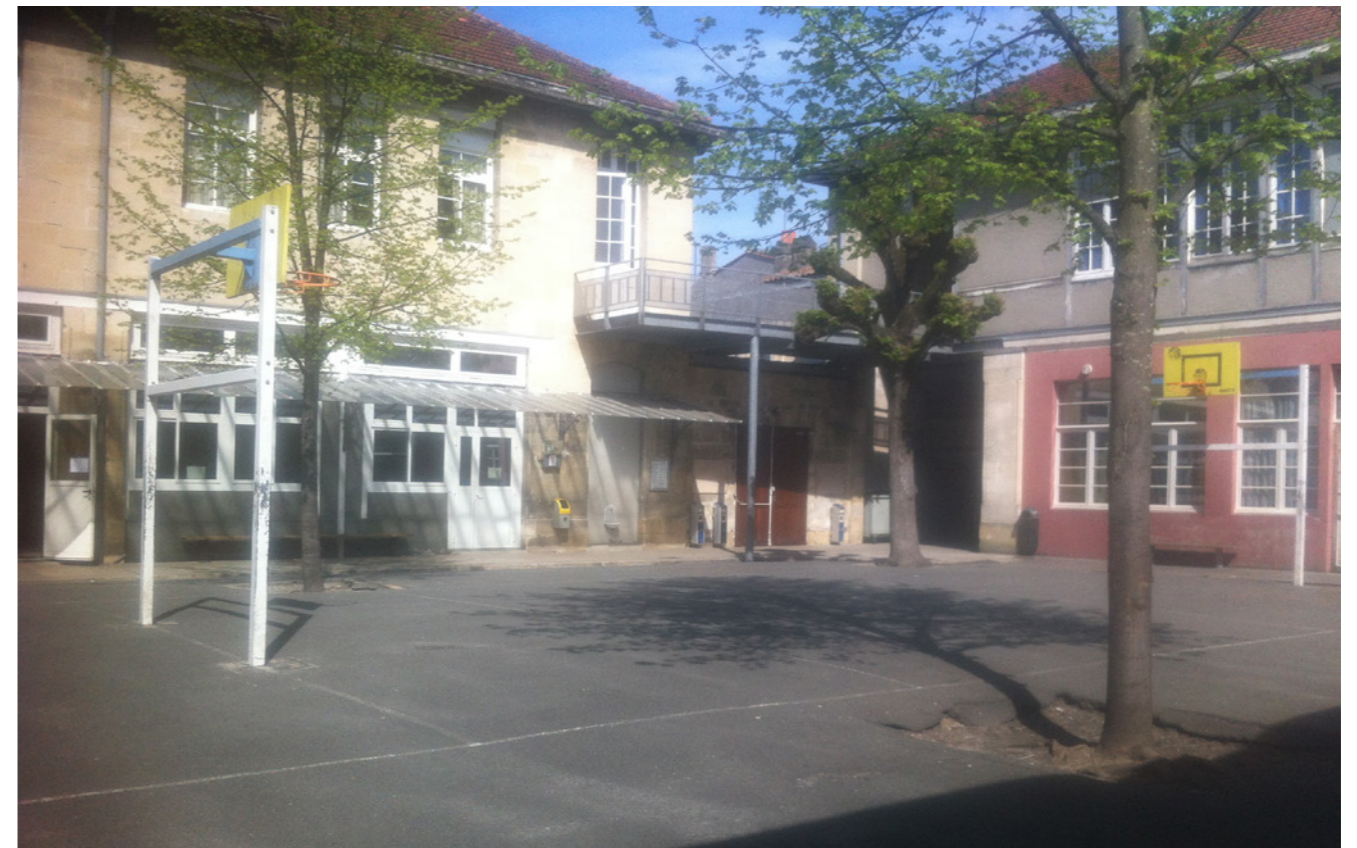
653 5- Façade Nord de l'école élémentaire
