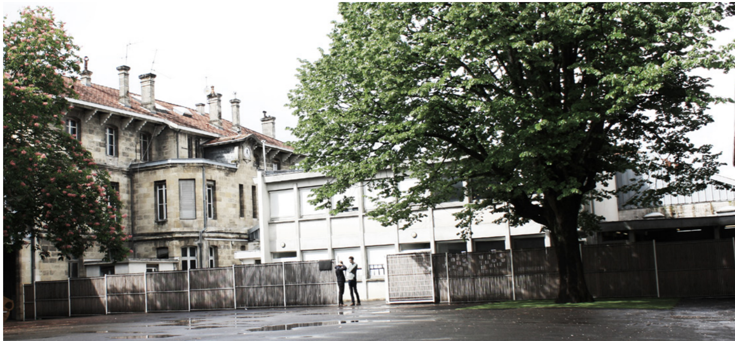
3- Façade Ouest et vue du bâtiment Greta
