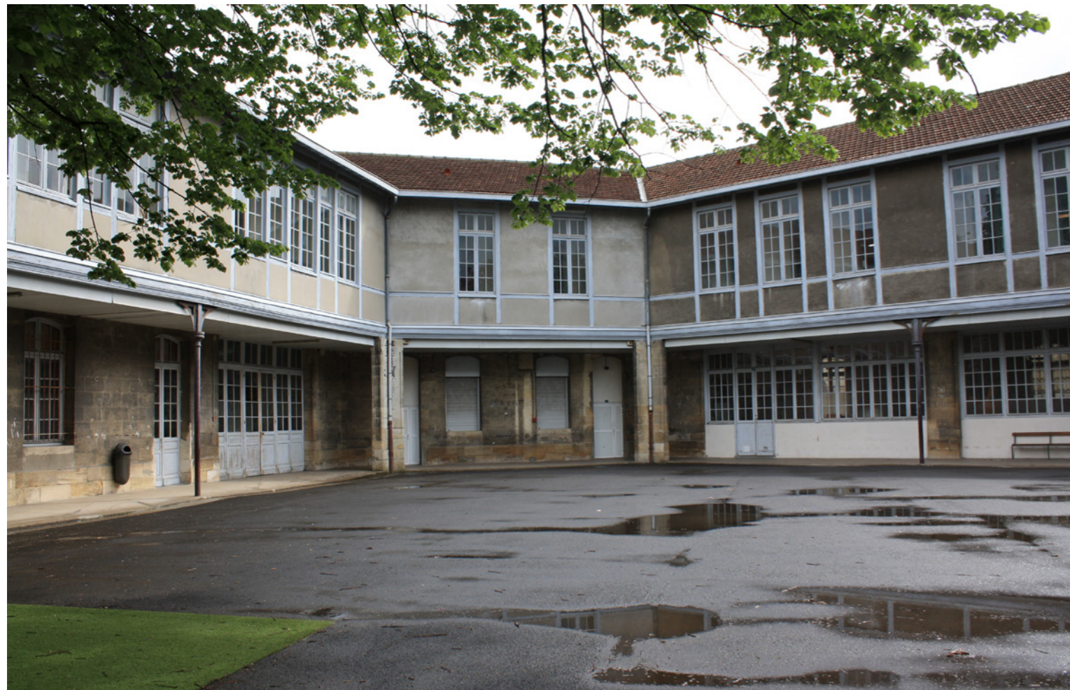
2- Façade Sud de l'Annexe Montesquieu
