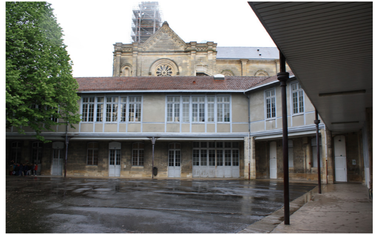
1- Façade Est de l'Annexe Montesquieu
