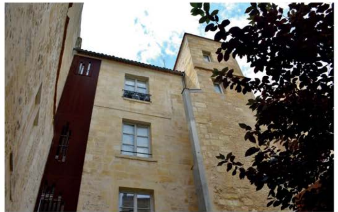
Immeuble du 26 rue Buhan vue depuis la cour
