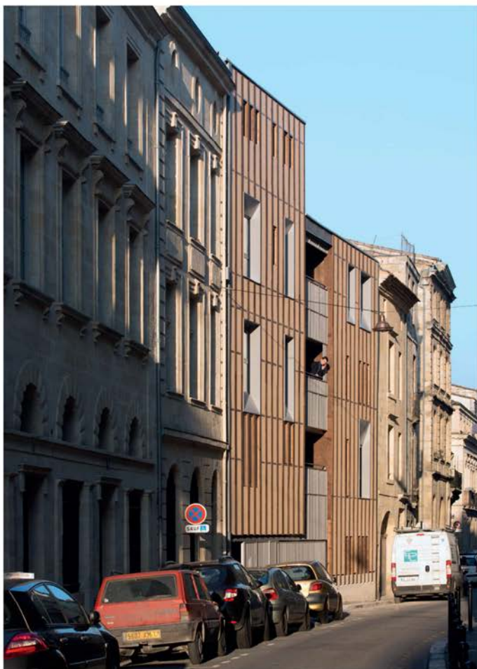
Opération Triptik, rue Carpenteyre, Bordeaux
