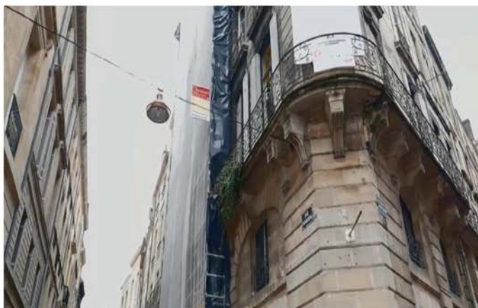
1-3 rue Bouquière en cours de ravalement
