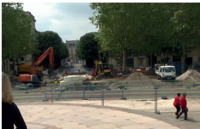
Le chantier de la ligne D cours Tournon, bordeaux
