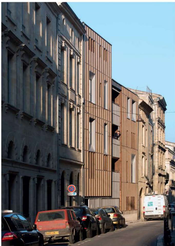
Opération Triptik, rue Carpenteyre, Bordeaux
