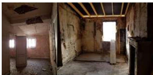
7 rue Veyrines sécurisation
