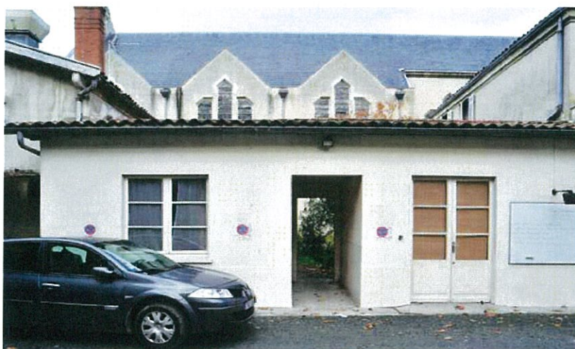
Zone d'entrée : bâtiment des cuisines - Entrée à droite =>
