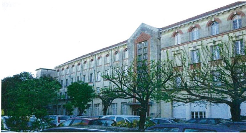
Bâtiment en R+3 sur le parc
