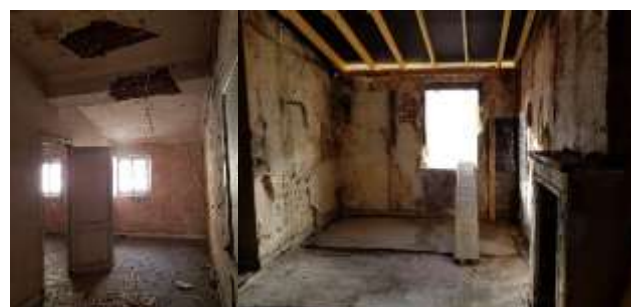
7 rue Veyrines sécurisation
