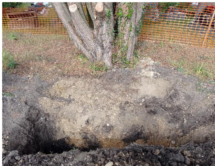
Photo n°7 : quelques racines sectionnées sur l'arbre n°10 (noté V9)
